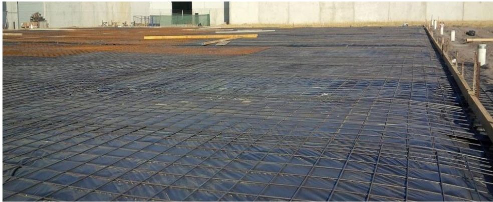
Le film polyane pour dalle béton
